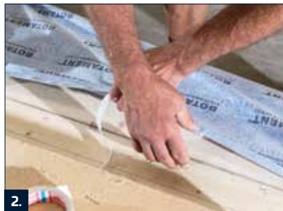
2. PB Portalichtband am Wandelement mit dem Klebstreifen fixieren.
