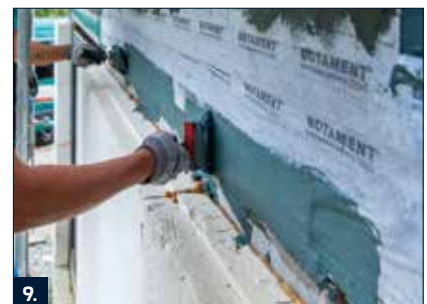
9. PB Portalichtbands faltenfrei in die frische Abdichtung aus RD 2 einbetten und den Übergang großzügig mit RD 2 überarbeiten.
