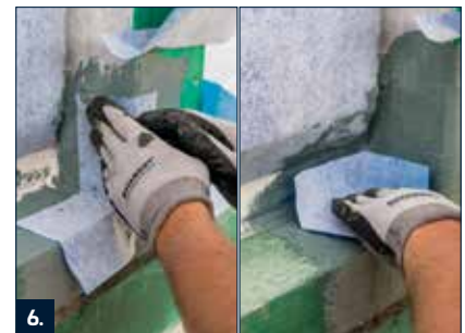
6. Zugeschnittene Formteile vollflächig in RD 2 einlegen und faltenfrei eindrücken.
