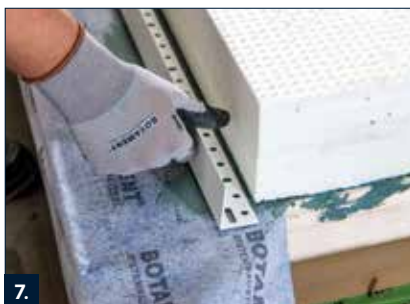
7. Sockelabschlussprofil in die frische Abdichtung aus RD 2 einarbeiten.
