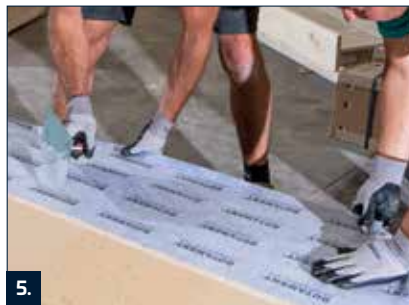
5. PB Portalichtband faltenfrei in die frische Abdichtung aus RD 2 einbetten.
