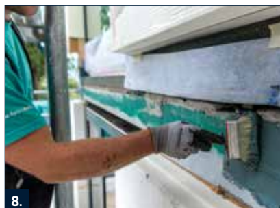
8. Überstehendes PB Portalichtband nach der Montage des Wandelements auf der Baustelle an der Bodenplatte oder Sockelabdichtung anschließen. Dazu Abdichtungsuntergrund vollflächig mit RD 2 auf durchgetrockneter Kratzspachtelung versehen.
