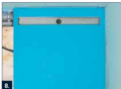
8. Alle Bauteilschichten bündig mit dem Duschboard abschneiden, um ein späteres Anarbeiten des Fußbodenaufbaus zu ermöglichen.
