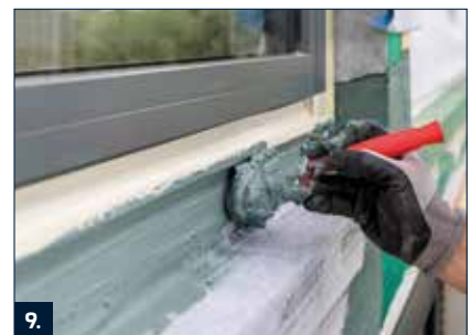
9. Um eine Hinterläufigkeit der Dichtbänder zu vermeiden, mindestens die Enden des PB Portalichtbandes mit RD 2 überarbeiten.
