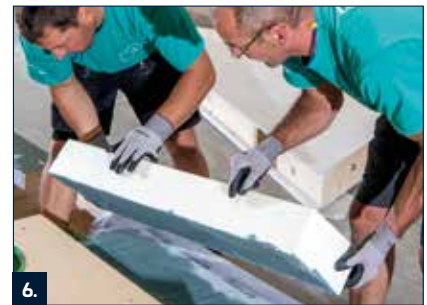
6. Die zugeschnittene Sockeldämmplatte mit RD 2 im Buttering-Floating-Verfahren vollflächig auf dem PB Portalichtband verkleben.
