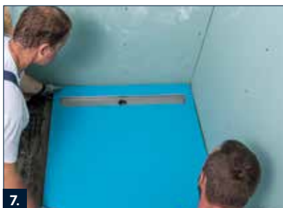
7. LD Duschboard mit Linienentwässerung, vorgefertigtem Gefälle und ab Werk erstellter Abdichtung in den frischen Estrich einbetten und in Höhe und Richtung ausrichten.
