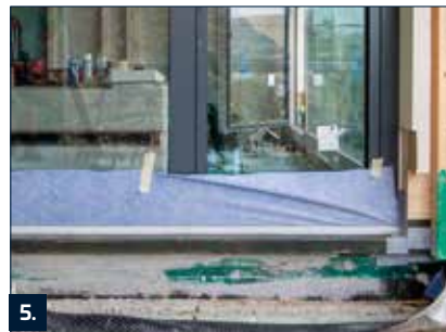
5. Zur Erleichterung des Arbeitsablaufs PB Portalichtband provisorisch mit Klebeband am Fenster ankleben.
