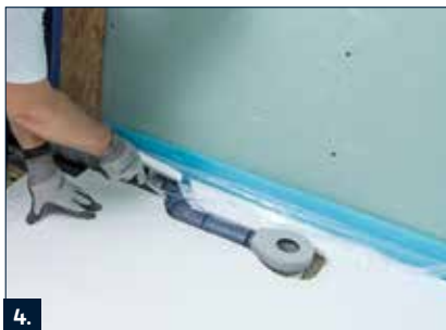
4. Auf der Installationsebene die Trittschalldämmung verlegen.
