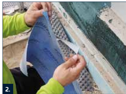
3. PB Portal-dichtband 15 cm über Geländeoberkante fixieren.
