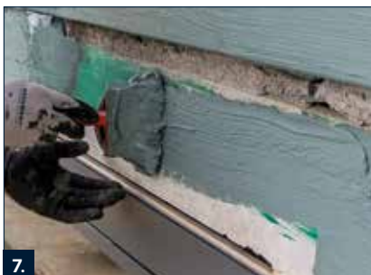
7. Die Untergründen, auf denen das Portalichtband verklebt werden soll, werden vollflächig mit RD 2 mit einem Flächenstreicher oder einem Zahnglätter versehen.
