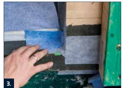
3. Bei verwinkelten Ecken PB Portalichtband und die zugehörigen Systemkomponenten wie Innen- und Außenecken im Vorfeld zurechtschneiden.
