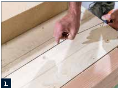
1. Abdichtungshöhe einmessen und anzeichnen.
