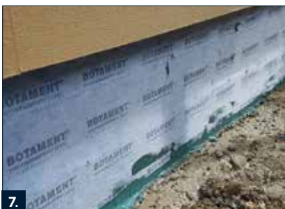
7. Portal-dichtband faltenfrei einbetten.
