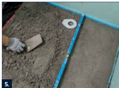
5. Auf Ölpapier oder PE-Folie Estrich aus M 54 FM Schnelllestrich-Fertigmörtel waagrecht in der gewünschten Höhe erstellen.
