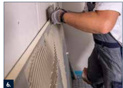
6. Rückseite des LD Duschboards mit M 21 Classic Fliesenkleber versehen.
