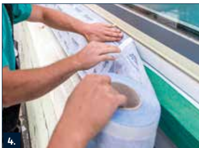
4. Mithilfe des Klebestreifens PB Portalichtband am Fensterelement fixieren.
