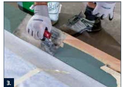
3. PB Portalichtband umschlagen und Kratzspachtelung aus RD 2 auftragen.
