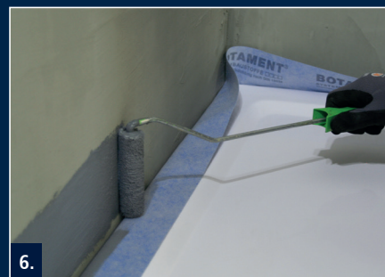
6. Wannendichtband in die erste Lage der Verbundabdichtung einbetten
