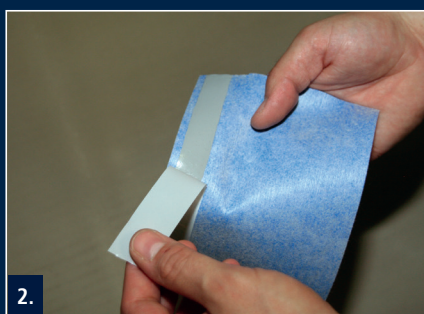
2. Schutzfolie vom Butylstreifen abziehen und das Band blasen- und faltenfrei (ohne Unterbrechung in den Eckbereichen) ankleben
