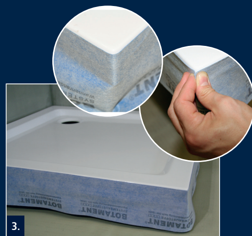
3. Optional (abhängig vom Wannenradius): Ausbilden einer Tasche zur Herstellung einer spannungsfreien Innenecke
