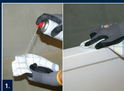
1. Wannenrand vorab mit lösemittelfreiem Reiniger säubern
