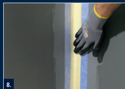
8. Beispiel: Einbau Systemdichtband SB 78 mit aufgeklebtem Schnittschutz/ Einbettung in die erste Lage der Verbundabdichtung
