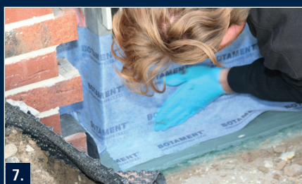
7. Portaldichtband in die frische Reaktivabdichtung einbetten
