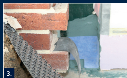
3. RD 2 mit einem Quast oder Pinsel auftragen und Formteile, hier Innenecken, einsetzen
