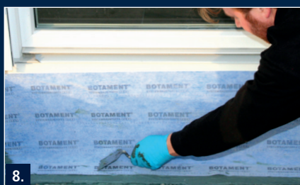
8. Portaldichtband sorgfältig in die frische Abdichtung einstreichen
