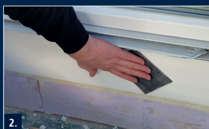
2. Untergrund mit Schleifpapier anrauen
