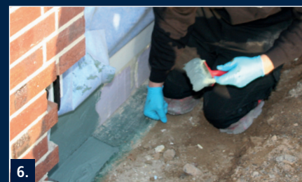
6. Untergrund mit RD 2 mit Pinsel, Quast oder 4 mm Zahngläter versehen
