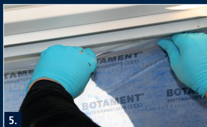
5. Zugeschnittenes Portaldichtband mit dem Klebstreifen am Fensterrahmen fixieren
