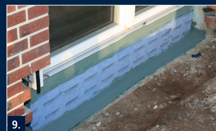
9. Übergänge vom Portaldichtband zur vorhandenen Bauwerksabdichtung und zum Fensterelement mit einem Quast oder Pinsel großzügig überarbeiten
