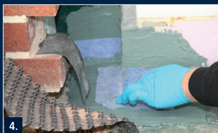
4. Botament RD 2 mit einem Quast oder Pinsel auftragen und Formteile, hier Außenecken, einsetzen
