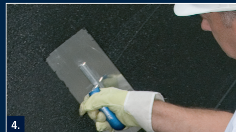
Vollflächiges Spachteln der zweiten Lage.
