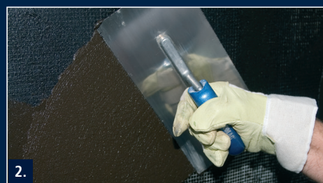
Auftrag der zweiten Lage Bitumen-Dickbeschichtung.
