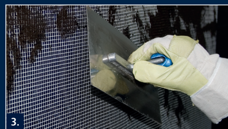
Je nach Lastfall: Verstärkungseinlage GS 98 in die erste Lage einarbeiten.
