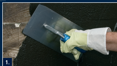
Aufragen der ersten Lage Bitumen-Dickbeschichtung.
