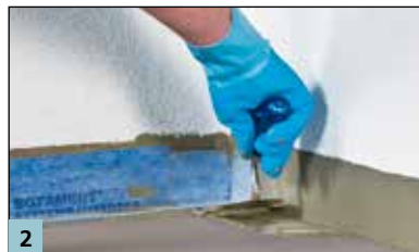
Einarbeitung von SB78 Dichtband und Innenecke in M 21 HP / M 21 HP Speed.
