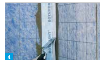
4 Auftragen der Dichtmanschetten an den Armaturen mit den Fliesenklebern
