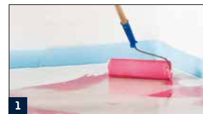
Die Grundierung von saugfähigen Bodenflächen erfolgt mit D11.
