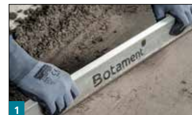
1 Der Schnellestrich-Fertigmörtel M54 FM wird nach dem Aufbringen einer Kontaktschlämme und Stellung eines Randstreifens auf den tragenden Untergrund aufgebracht.
