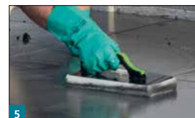
5 Direkt nach dem Einfügen wird die Fuge in Form gebracht und der Belag mit einem Hydroschwamm abgewaschen.
