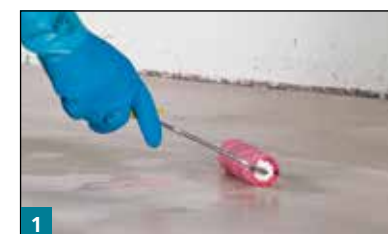
1 Grundierung des Untergrunds mit dem Tiefengrund D11
