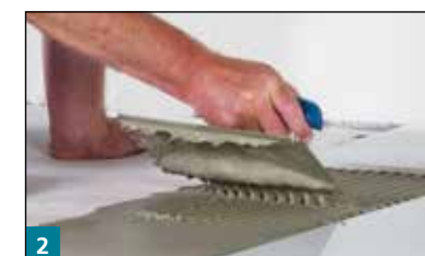
2 Kunstharzgebundenen Platten: Aufziehen des Epoxidharz-Fugen- und Klebemörtel EKF500 oder MULTISTONE in Fließbettkonsistenz mit einem ausreichend großen Zahnlätter. Bei großformatigen Platten: MULTISTAR in Fließbettkonsistenz mit einem ausreichend großen Zahnlätter
