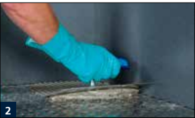
2 Aufziehen von EKF500 auf den Metalluntergrund.
