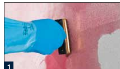
1 Grundierung des Untergrunds mit D11.
