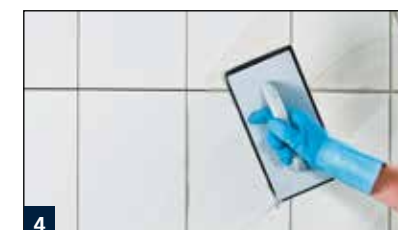
5 Verfugung mit MULTIFUGE Base oder MULTIFUGE Fine.
