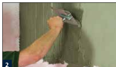
2 Aufziehen von MULTISTAR oder MULTISTONE mit entsprechend großem Zahnpachtel.
