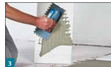
3 Rückseitiges Aufspachteln von EKF500, MULTISTONE oder MULTISTAR auf der Plattenrückseite
