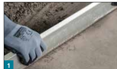
1 Ein ausreichendes Gefälle mit z.B. M54/FM erstellen.
