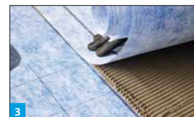
3 Verlegen der Abdichtungs- und Entkopplungsbahn in M21 Classic/M21 HP/M21 HP Speed mit 5 cm Überlappung.
