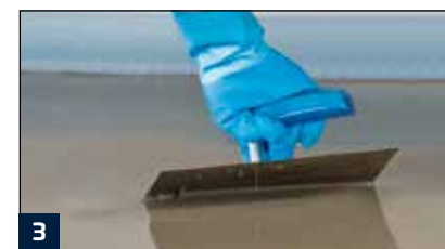
Verteilen der ausgegossenen Nivelliermasse M50 Classic mit dem Glätter.
