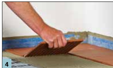
Verlegen der Platten mit M21 HP / M21 HP Speed im kombinierten Verfahren.
