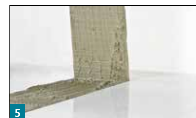
5 Kontrolle der Benetzung durch Aufnahme der Fliese
