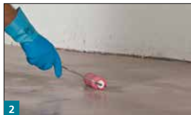
2 Estrich mit D11 Tiefengrund grundieren.
