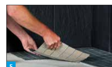
5 Verlegung des Belags mit M 21 Classic/M 21 HP/ M 21 HP Speed.
