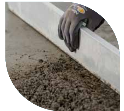
Bereits nach ~ 4 Stunden ist ein neuer Estrich aus M56 Speed FM mit Fliesen belegbar.
