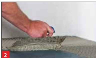
2 Aufziehen von MULTISTAR oder MULTISTONE mit entsprechend großem Zahnspatel.
