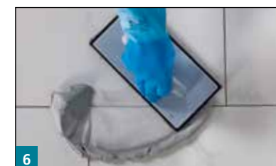
6 Verlegung des großformatigen Belages mit MULTIFUGE Base, MULTIFUGE Fine, MULTIFUGE Fine Speed oder MULTIFUGE Diamond Max
