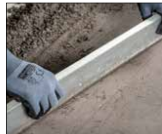
Erstellen von Verbund- und Gefälleestrichen
