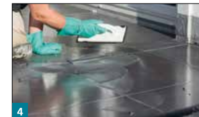
4 Mit einem Epoxidharzfugbrett kann Multifuge Diamond Max leicht eingefügt werden. Verarbeitungs- und Untergrundtemperatur + 10 °C bis + 25 °C.
