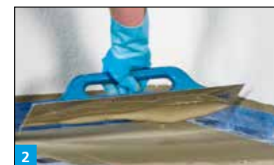
2 Aufziehen von M21 Classic M21 HP/M21 HP Speed nach Einarbeitung von SB78 Dichtband und Innenecke.
