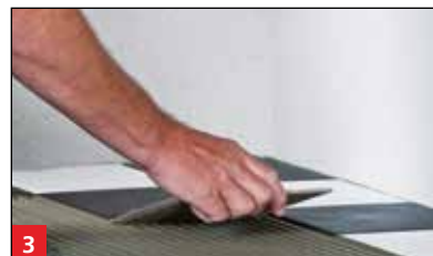
3 Einlegen der Fliesen in das Kleberbett aus MULTISTAR oder MULTISTONE
