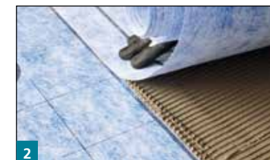
2 Nach dem Aufrollen und Trocknen der Grundierung D11 klebt man die AE Abdichtungs- und Entkopplungsbahn mit M21 HP Speed unter Verwendung eines 4 mm Zahnpachtels auf.
