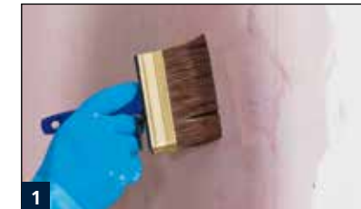
1 Grundierung des Untergrunds mit dem einkomponentigen Tiefengrund D11.
