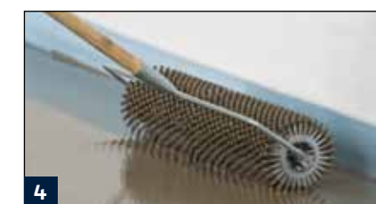
Entlüftung der Ausgleichsschicht mit einer Stachelwalze.
