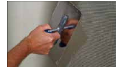
2 Alternativ bei Bauplatten: Im Stoßbereich der Bauplatten ist zur Vermeidung der Rissbildung eine Gewebeeinlage aus GS12 einzubetten.
