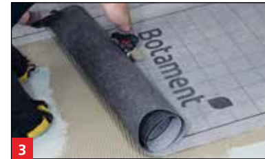
3 Einlegen der ATE Max Abdichtungs- Trittschall- & Entkopplungsbahn in MULTISTONE
