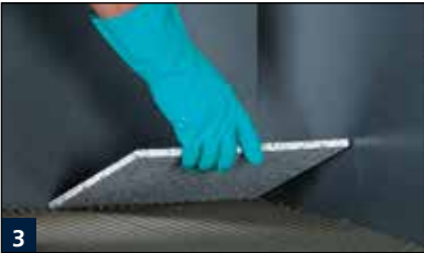
3 Einlegen der Fliesen in EKF500. Ein entsprechend großer Zahnpachtel ist zu wählen, um eine gute Benetzung zu erreichen.
