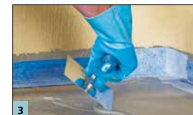
3 Einarbeitung von SB78 Dichtband und Innenecke in MD1 Speed oder Multirproof.
