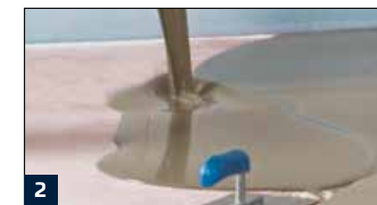
Ausgießen der Nivelliermasse M50 Classic.
