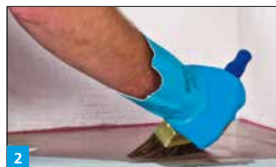
2 Grundierung der Gefälleschicht mit D11.
