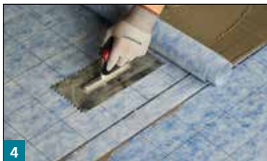
4 AE-Abdichtungs- und Entkopplungsbahn ins frische Kleberbett einlegen und andrücken.
