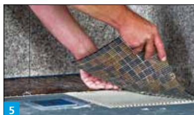
5 Einlegen der Fliesen in das Kleberbett aus MULTISTAR oder MULTISTONE.
