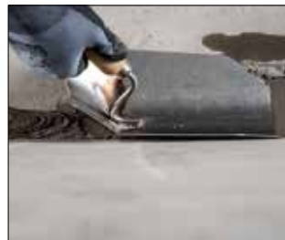
Herstellen von Hohikehlen im Sockelbereich
