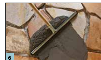
6 Verfugung mit MULTIFUGE Base
