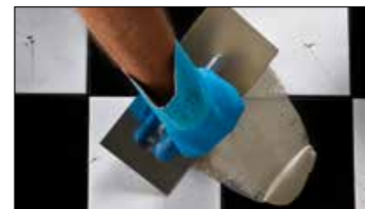
Erstellung einer Haftbrücke aus MD1 Speed auf einem alten Terrassenbelag.
