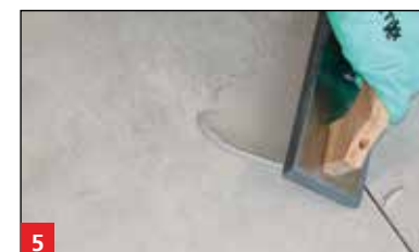
5 Verfugung des Belages mit Multifuge Base oder Multifuge Fine Speed
