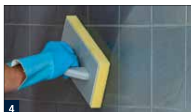
4 Leichtes, schleierfreies Waschen der Fuge.
