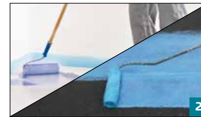
Grundierung alter festhaftender Beschichtungen mit D1 Speed.
