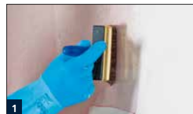
1 Grundierung des Betons mit der einkomponentigen Grundierung D11. Vor der Grundierung ist der Beton auf Sinterschichten und Schalölreste zu prüfen.
