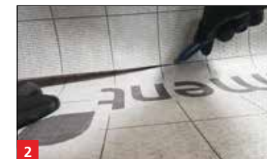
2 Einfaches Schneiden der ATE Max Abdichtungs- Trittschall- & Entkopplungsbahn mit dem Teppichmesser
