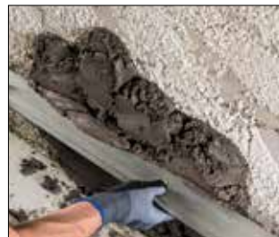
Verputzen von Wandflächen im Innen- und Außenbereich
