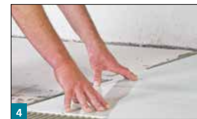
4 Sorgfältiges Einschieben der Fliesen in das Kleberbett
