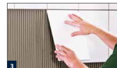
4 Einlegen der Fliesen in das Kleberbett aus MULTISTAR oder MULTISTONE.
