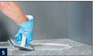
5 Verfugung mit MULTIFUGE Base oder MULTIFUGE Fine.
