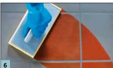
Leichtes, schleierfreies Waschen der MULTIFUGE Base/MULTIFUGE Fine Speed.
