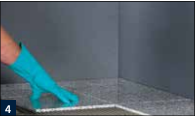
4 Einschieben der Fliesen in das Kleberbett.
