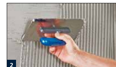
3 Aufziehen von MULTISTAR oder MULTISTONE mit entsprechend großem Zahnpachtel.
