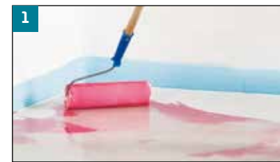
Die Grundierung von saugfähigen Bodenflächen erfolgt mit D11. Alternativ kann D11 mit dem Pinsel aufgetragen werden.
