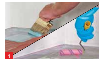
1 Grundierung der lackierten Holzdielen mit D1 Speed, alternativ bei rissigem Estrich mit D11
