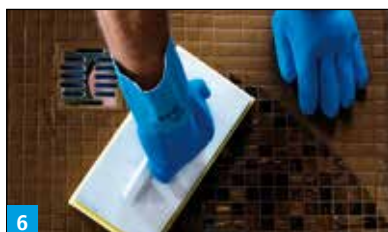
6 Leichtes, schleierfreies Waschen der Fuge.
