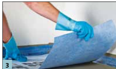
Einlegen der AE Abdichtungs- und Entkopplungsbahn in M21 HP / M21 HP Speed mit 5 cm Überlappung.
