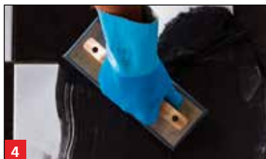
4 Verfugung mit MULTIFUGE Base oder MULTIFUGE Fine Speed.
