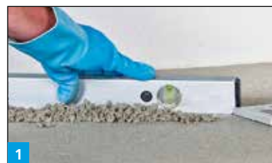
1 Aufziehen der Gefälleschicht, hergestellt aus M200.
