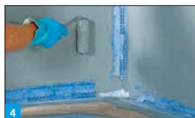
4 Ausrollen der Abdichtungsfolie DF9 in zwei Lagen (alternativ: Multiproof oder MD1 Speed).
