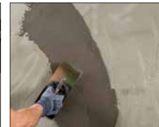
Ausbessern von Fassaden und Außenwänden
