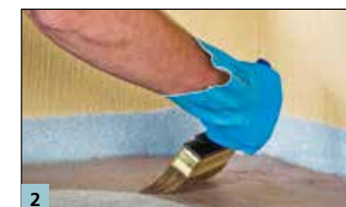
2 Grundierung der Gefälleschicht mit D11
