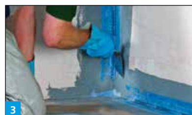
3 Einlegen des SB78 Dichtbands inklusive der Innen- und Außenecken.
