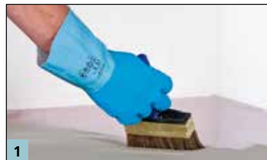
Grundierung des Estrichs mit D11.
