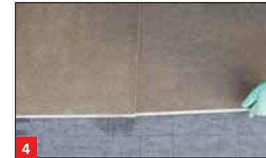
4 Verlegen der Fliesen auf der ATE Max mit MULTISTONE
