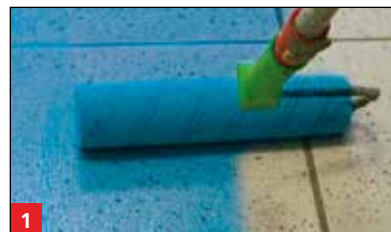
1 Grundierung des Untergrundes mit D1 Speed. Kratzspachtelung mit MD1 Speed.
