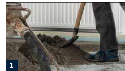
1 Aufbringen von M56 Speed FM auf die Trennlage
