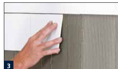
3 Aufziehen und Einlegen der Fliesen in das Kleberbett von MULTISTAR oder MULTISTONE
