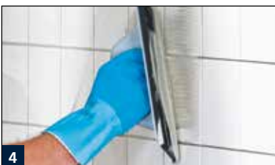
4 Boden mit Multifuge Base, Multifuge Fine Speed. Wand mit Multifuge Fine
