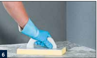
6 Leichtes, schleierfreies Waschen der Fuge.
