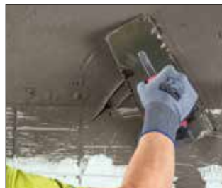
Ausgleichen, Spachteln und Verputzen von Unebenheiten
