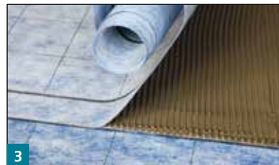
3 M21 HP Speed mit einem 4 oder 6 mm Zahnglätter aufkämmen.
