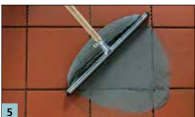
Verfugung der Platten mit MULTIFUGE Base oder MULTIFUGE Fine Speed.
