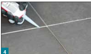
6 Der Fugenverschluss erfolgt mit S5 Supax
