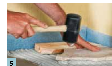
5 Verlegen der unkalibrierten Natursteine mit MULTISTONE/M29 HP
