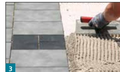
3 Der BTK200 Terrachamp wird mit einem Zahnpachtel passend zur Formatgröße des Belags aufgekämmt. Das kombinierte Verfahren und die damit verbundene hohlraumfreie Verlegung sind hierbei nicht erforderlich.
