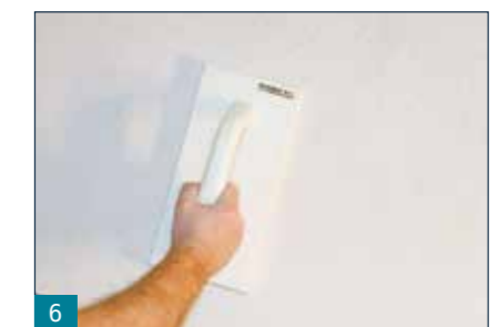
6 Glätten des Feinputzes RENOVATION FP
