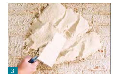
3 Aufbringen des Feuchtespezialputzes RENOVATION FSP Feuchtespezialputz
