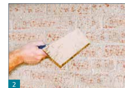
2 Netzförmiges Auftragen des Vorspritzmörtels RENOVATION VSM in Form eines Spritzbewurfs
