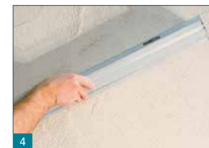
4 Glätten mit der Putzschiene
