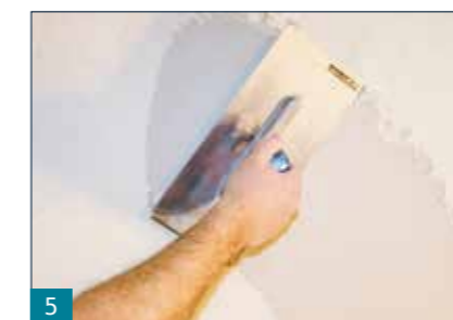
5 Optional Aufbringen des Feinputzes RENOVATION FP
