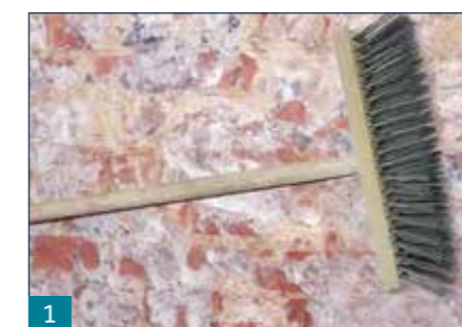
1 Vorbereitung des Untergrundes
