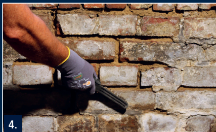
4. Fugen und Wandoberfläche gründlich von Verunreinigungen und losen Teilen reinigen.
