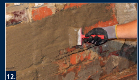
12. Sulfatbeständige Dichtungsschlämme Botament MS 30 auftragen.
