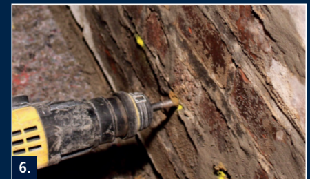
6. Bohrlöcher (Durchmesser 12 mm, alle 10 cm) anzeichnen und horizontal in die Fuge des Mauerwerks bohren. Bohrlöchtiefe = Wanddicke - 3 cm.
