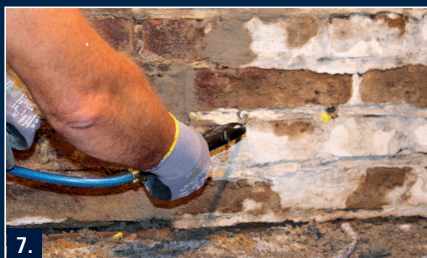
7. Bohrlöcher mit Druckluft reinigen.
