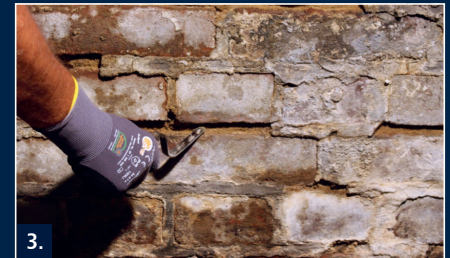
3. Mürbe Mauerwerksfugen 2 cm tief auskratzen.
