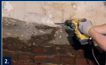
2. Schadhafte Putz bis mindestens 80 cm über der Durchfeuchtungsgrenze entfernen.
