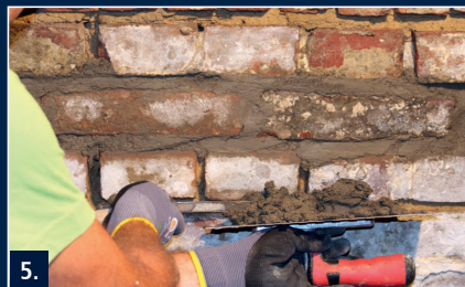
5. Offene Fugen mit Botament M 36 Speed schließen.
