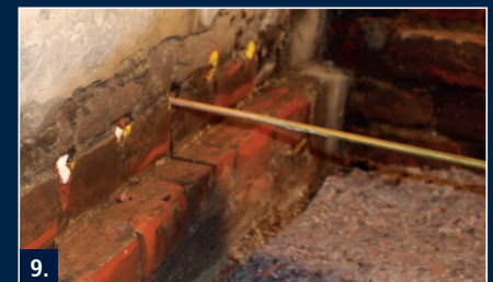
9. Um ein gleichmäßiges Füllen der Bohrlöcher zu gewährleisten, sollte das Material mit wenig Druck verarbeitet werden.
