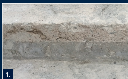
1. Lose Teile von Beton oder Estrich entfernen bis ein tragfähiger Untergrund entsteht.
