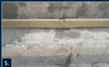
5. Spachtelung kann in Waage oder im Gefälle aufgebracht werden.
