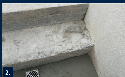
2. Auch größere Ausbrüche bis 3 cm können in einem Arbeitsgang ausgeglichen werden
