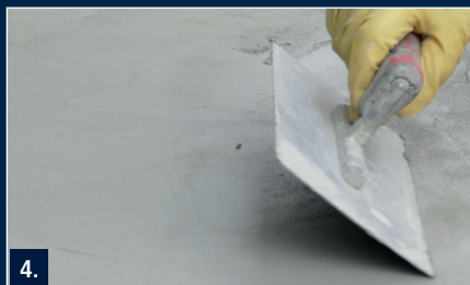
4. Frisch-in-frisch auf der Kontaktschicht Material aufbringen und eine ebene Fläche herstellen
