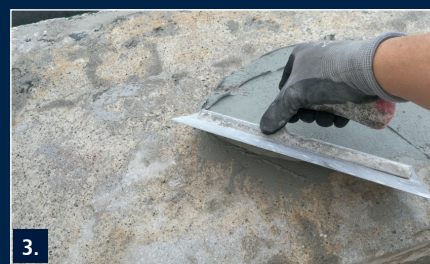
3. Tragfähigen Untergrund gut vorhassen und zunächst eine Kontaktschicht aufkratzen
