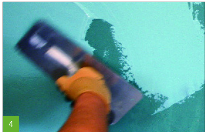
Aufbringen der ersten und zweiten Lage BOTAMENT® RD 2 The Green 1
