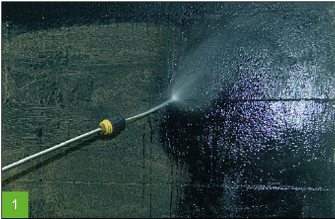
Untergrund reinigen z.B. mittels Hochdruckreiniger
