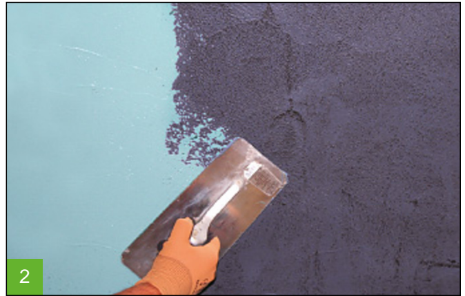
Kratzspachtelung als Haftbrücke
