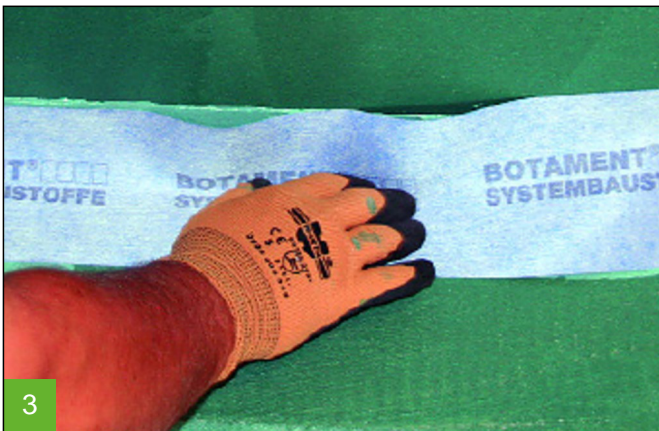
Herstellen des Wand-Bodenanschlusses mit BOTAMENT® SB 78
