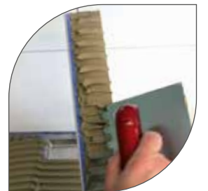
Einfache Höhenjustierung mittels Fliesenkleber
