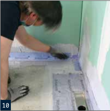
10 Einarbeiten der SB78 Dichtbänder in Multiproof.
