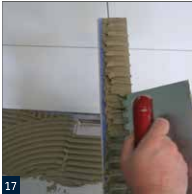
17 Auftragen von Fliesenkleber auf der Profilrückseite.
