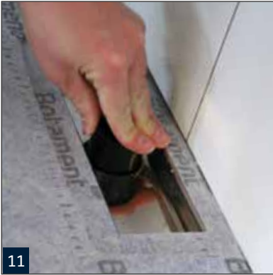
11 Einsetzen des Geruchsverschlusses.
