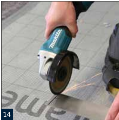
14 Optional: Variables ablängen der Water LD V mittels langsam laufender Flex mit entsprechend geeigneten Trennscheiben.
