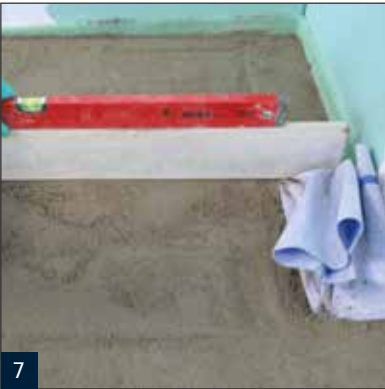
7 Erstellen eines Gefällestrichs mit ausreichendem Gefälle.
