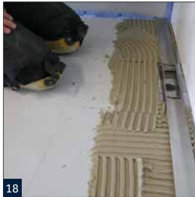
18 Höhenjustierung der Water LD V.
