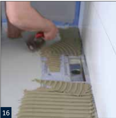
16 Auftragen von geeignetem Botament Fliesenkleber.
