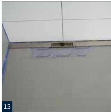
15 Nachträgliche Kontrolle der Ausrichtung von Water LD V.
