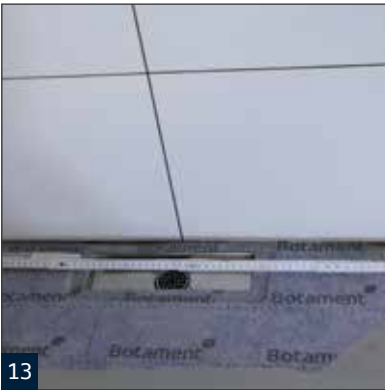
13 Ausmessen der erforderlichen Länge.
