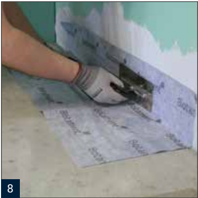
8 Einarbeiten der werksseitig angebrachten Dichtmanschette mit Multiproof.
