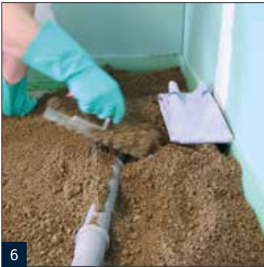
6 Unterfüttern des Rinnenkörpers mittels M 54 FM Schnellestrich-Fertigmörtel.
