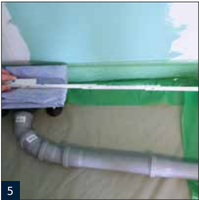
5 WATER LD V ausrichten.
