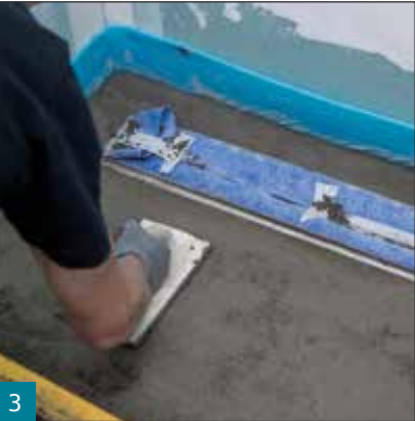
3 Abreiben der Estrichoberfläche.
