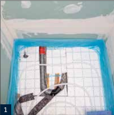
1 Befestigung des RS Randdämmstreifen im Wandbereiches.
