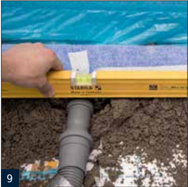
9 Nachträgliche Kontrolle der Ausrichtung von Water LD.
