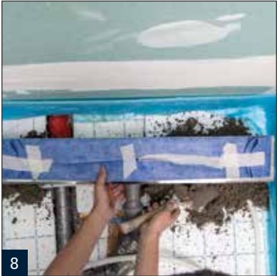
8 Unterfüttern der Rinne mit M 54 FM Schnellstrich-Fertigmörtel.
