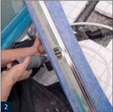
2 Anschluss des optionalen Flex-Schlauches.
