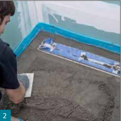
2 Erstellen des Estrichs mit M 54 FM.
