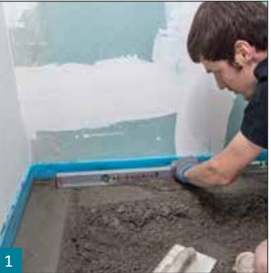
1 Erstellung der Estrich-Abziehlehren aus M 54 FM Schnellstrich-Fertigmörtel.
