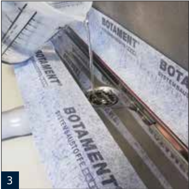
3 Angeschlossen Linienentwässerung auf Dichtheit prüfen.
