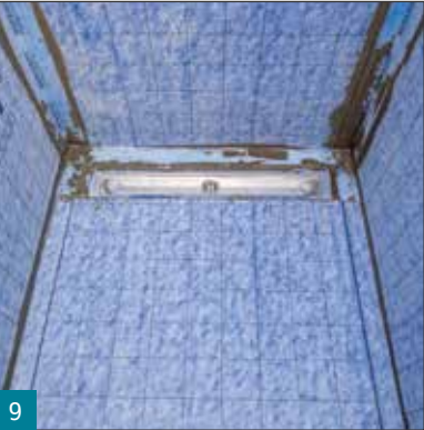
9 Fertig abgedichteter Duschplatz.
