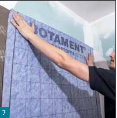
7 Verlegen von AE Abdichtungs- und Entkopplungsbahn mit M 21 Classic, M 21 HP Premium Flex-Schnellkleber oder M 21 HP Speed im Wandbereich.
