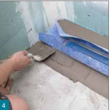
4 Eindichten der werksseitigen angebrachten SB 78 Dichtmanschette in M 21 Classic Flex-Leistungskleber, M 21 HP Premium Flexkleber oder M 21 HP Speed Premium Flex-Schnellkleber.
