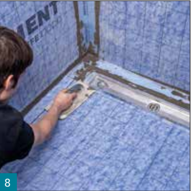
8 Verlegen der AE Bahn im Bodenbereich.
