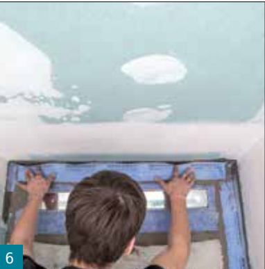
6 Einarbeiten von SB 78 Sanitärabdichtband in M 21 Classic, M 21 HP Premium Flex-Schnellkleber oder M 21 HP Speed.
