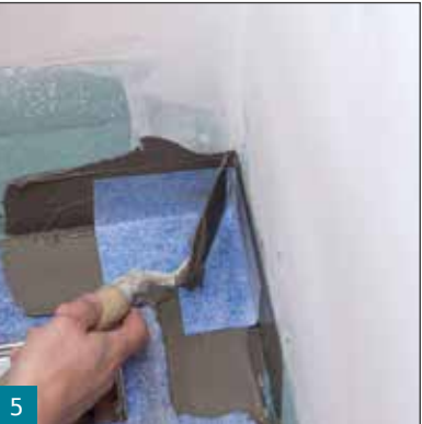
5 Einarbeiten von SB 78 Innenecken in M 21 Classic Flex-Leistungskleber, M 21 HP Premium Flexkleber oder M 21 HP Speed Premium Flex-Schnellkleber.
