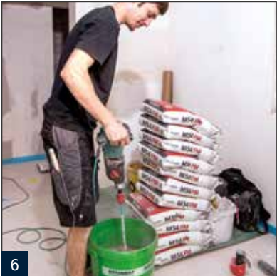
6 Anmischen M 54 FM Schnellstrich-Fertigmörtel.
