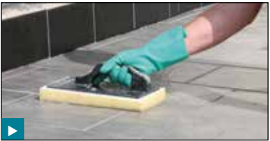
Nach dem Anziehen der Fuge wird diese mit einem Schwammbrett in Form gebracht und das überschüssige Material abgewaschen.
