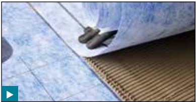
Nach Aufrollen und Trocknen der Grundierung D11 klebt man die AE Abdichtungs- und Entkopplungsbahn mit M21 HP Speed unter Verwendung eines 4 – 6 mm Zahnpachtels auf. Die Stöße sind in Fließrichtung zu überlappen.
