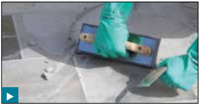
Mit einem Epoxidharzfugbrett kann Multifuge Diamond Max leicht eingefügt werden.
