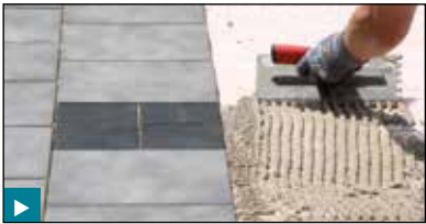
Der BTK200 Terrachamp wird mit einem Zahnpachtel passend zur Formatgröße des Belags aufgekämmt. Das kombinierte Verfahren und damit eine hohlraumfreie Verlegung ist nicht erforderlich!
