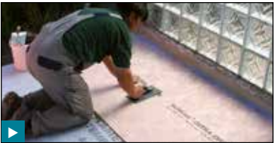
Die Drainagebahn wird nach Herstellerangaben aufgebracht. Bei der Festverlegung wird M21 HP Speed mit einem 6 x 6 mm Zahnpachtel aufgekämmt und anschließend die Drainagebahn mit einem Glätter durch Andrücken ins Kleberbett eingebettet.
