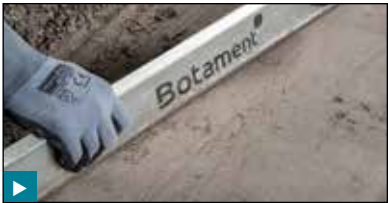
Der Schnellestrich M54 FM und M56 Speed FM wird nach dem Aufbringen einer Kontaktschlämme und Stellung eines Randstreifens auf den tragenden Untergrund aufgebracht.
