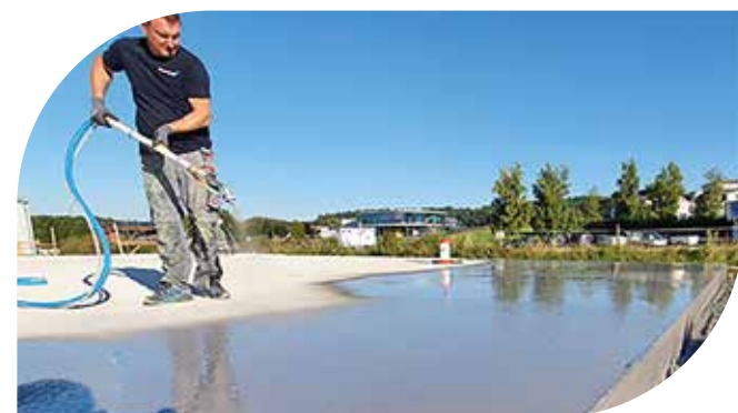
Abdichtung von erdberührten Bodenplatten. Neubau: besonders effizient bei maschineller Verarbeitung
