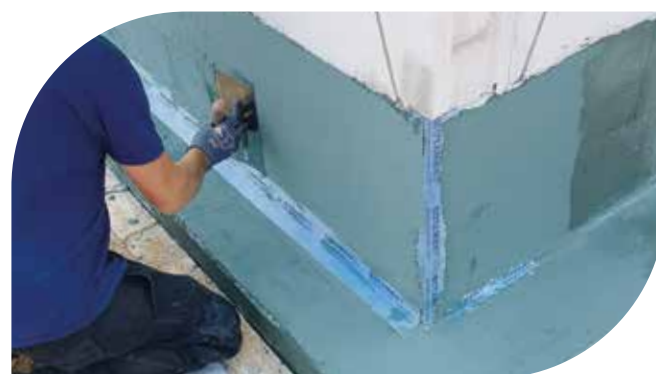
Effiziente Eckausbildung mit Dichtband
