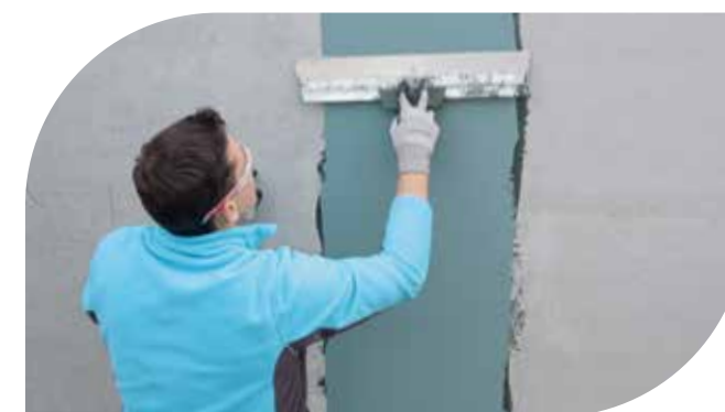
Streifenabdichtung bei WU-Betonkonstruktionen
