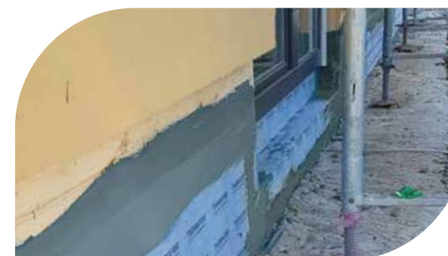
Sockelabdichtung im Holzbau
