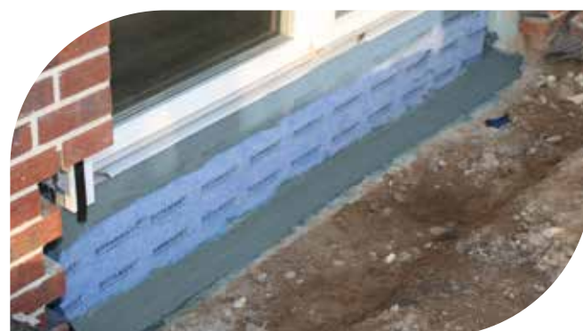
Fenster- und Detailabdichtung
