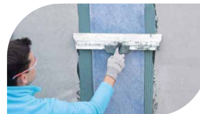
Fugenabdichtung und Abdichtung von WU-Betonbauteilen
