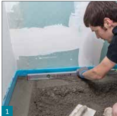
1 Erstellung der Estrich-Abziehle von M54 FM Schnellestrich-Fertigmörtel.
