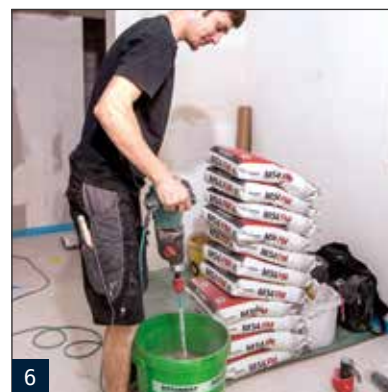
6 Anmischen M54 FM Schnellestrich-Fertigmörtel.
