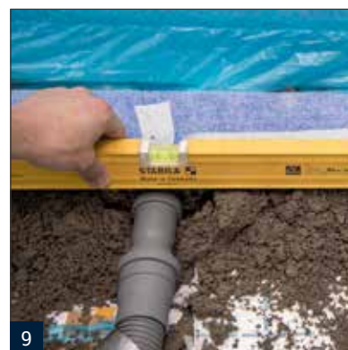
9 Nachträgliche Kontrolle der Ausrichtung von Water LD.
