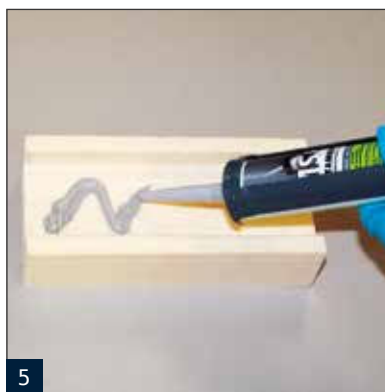
5 Aufstellen der Rinne inklusive erstellen aller Anschlüsse. Water LD mit MS6 Multifunktionaler Kleb- und Dichtstoff auf den XPS Kern
