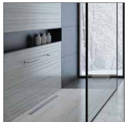
Fertig abgedichteter Duschplatz.
