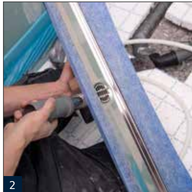
2 Anschluss des optionalen Flex-Schlauches.
