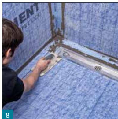
8 Verlegen der AE Bahn im Bodenbereich.
