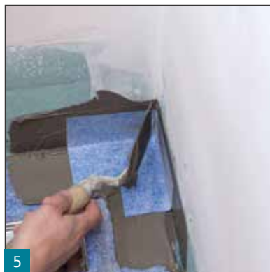
5 Einarbeiten von SB78 Innenecken in M21 Classic Flex-Leistungskleber, M21 HP Premium Flexkleber oder M21 HP Speed Premium Flex-
