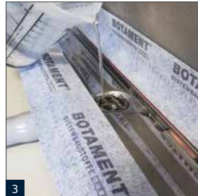
3 Angeschlossen Linienentwässerung auf Dichtigkeit prüfen.
