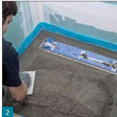
2 Erstellen des Estrichs mit M54 FM.
