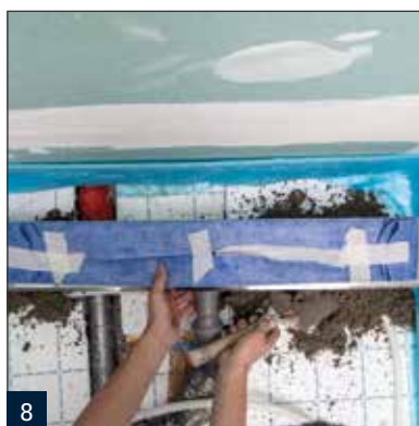
8 Unterfüttern der Rinne mit M54 FM Schnellestrich-Fertigmörtel.
