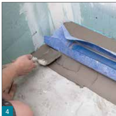
4 Eindichten der werksseitigen angebrachten SB78 Dichtmanschette in M21 Classic Flex-Leistungskleber, M21 HP Premium Flexkleber oder
