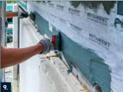
9. PB Portal-dichtbands faltenfrei in die frische Abdichtung aus RD 2 einbetten und den Übergang großzügig mit RD 2 überarbeiten.
