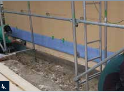
4. PB Portal-dichtband nach oben schlagen und mit Klebeband provisorisch anheften.
