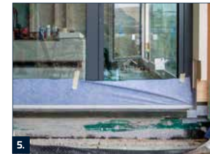
5. Zur Erleichterung des Arbeitsablaufs PB Portaldichtband provisorisch mit Klebeband am Fenster ankleben.
