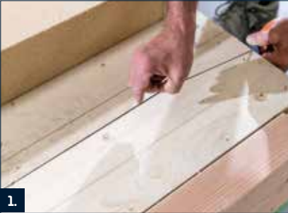
1. Abdichtungshöhe einmessen und anzeichnen.
