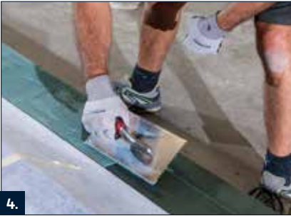
4. Auf der durchgetrockneten Kratzspachtelung RD 2 mit einem Zahnglätter vollflächig auftragen.
