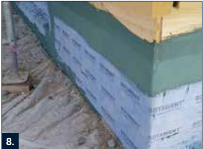
8. Enden und Übergänge des Portal-dichtbands mit RD 2 überarbeiten.
