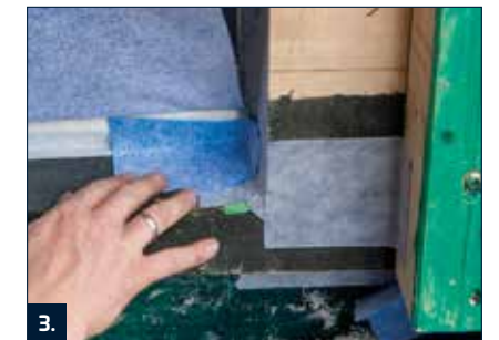
3. Bei verwinkelten Ecken PB Portaldichtband und die zugehörigen Systemkomponenten wie Innen- und Außenecken im Vorfeld zurechtschneiden.
