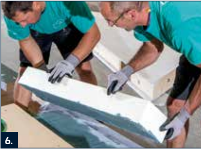
6. Die zugeschnittene Sockeldämmplatte mit RD 2 im Butting-Floating-Verfahren vollflächig auf dem PB Portal-dichtband verkleben.
