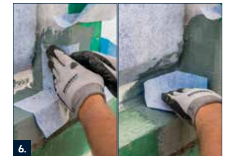
6. Zugeschnittene Formteile vollflächig in RD 2 einlegen und faltenfrei eindrücken.
