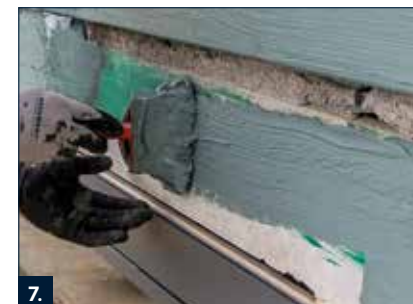
7. Die Untergründen, auf denen das Portaldichtband verklebt werden soll, werden vollflächig mit RD 2 mit einem Flächenstreicher oder einem Zahnglätter versehen.
