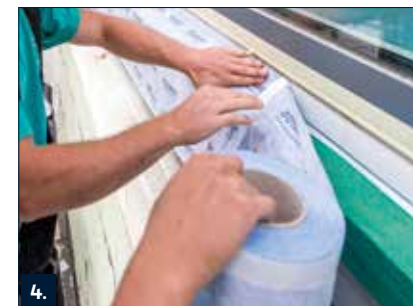
4. Mithilfe des Klebestreifens PB Portaldichtband am Fensterelement fixieren.
