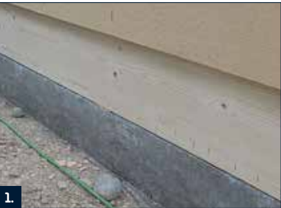
1. Die Abdichtung muss die Fuge zwischen Betonplatte und Holzkonstruktion dauerhaft überbrücken.
