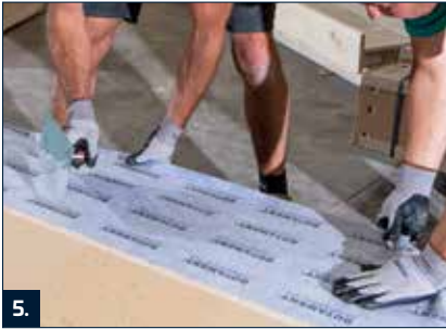
5. PB Portal-dichtband faltenfrei in die frische Abdichtung aus RD 2 einbetten.
