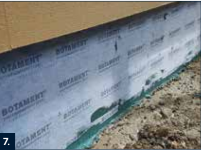
7. Portal-dichtband faltenfrei einbetten.
