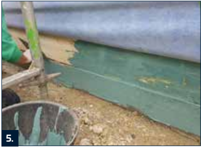
5. Betonflächen vornässen. Kratzspachtelung auf Beton- und Holzflächen aufbringen. Überschüssiges Material wieder entfernen.
