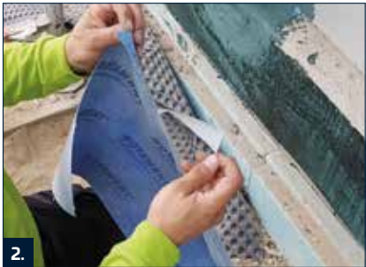
2. Klebestreifen an der Rückseite des PB Portal-dichtbands abziehen.
