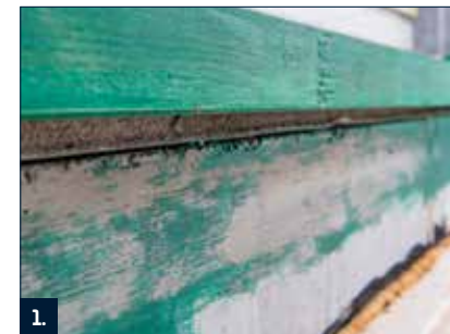
1. Die abzudichtenden Flächen mit einer Kratzspachtelung aus RD 1 oder RD 2 versehen.
