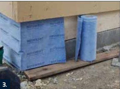
3. PB Portal-dichtband 15 cm über Geländeoberkante fixieren.
