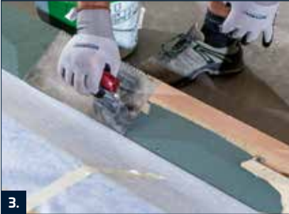
3. PB Portal-dichtband umschlagen und Kratzspachtelung aus RD 2 auftragen.
