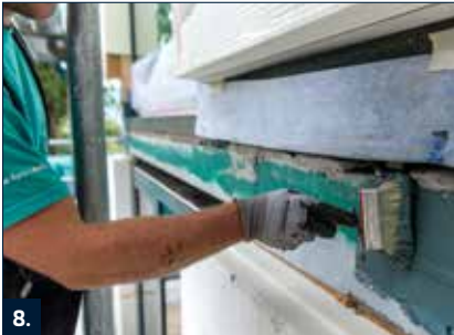
8. Überstehendes PB Portal-dichtband nach der Montage des Wandelements auf der Baustelle an der Bodenplatte oder Sockelabdichtung anschließen. Dazu Abdichtungsuntergrund vollflächig mit RD 2 auf durchgetrockneter Kratzspachtelung versehen.
