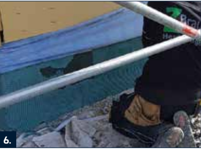
6. Auf der durchgetrockneten Kratzspachtelung vollflächig RD 2 mit einem Zahnglätter aufziehen.
