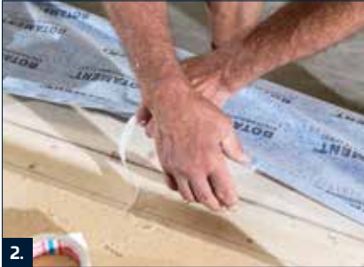
2. PB Portal-dichtband am Wandelement mit dem Klebestreifen fixieren.
