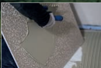
Zur Verlegung großformatiger Fliesen empfehlen wir zwecks nahezu hohlraumfreier Verlegung die Verarbeitung im kombinierten Verfahren.
