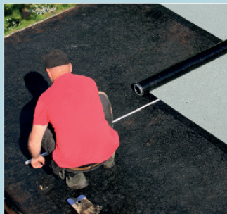
Zeit- und arbeitsintensiv: Abdichten mit Bitumenbahnen
