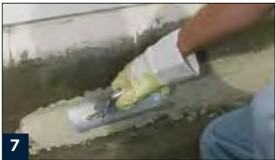
7 Herstellen der Hohlkehle mit M 36 Speed
