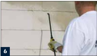
6 Grundieren mit D 12 Tiefenverkieselung
