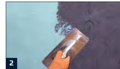
2 Kratzspachtelung als Haftbrücke
