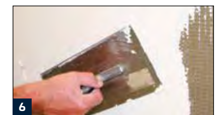
6 Einsatz von GS 4 zum Abspachteln von Bauplatten
