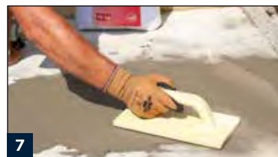
7 Abreiben der Oberfläche bereits nach wenigen Minuten möglich
