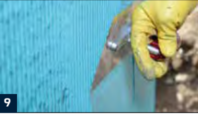
9 Stege im frischen Zustand glätten ohne Material wieder abzutragen. Auf der durchgetrockneten ersten Abdichtungsschicht die zweite Lage in der gleichen Arbeitsweise aufbringen.
