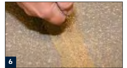
6 Abquarzen mit Quarzsand in das frische Gießharz
