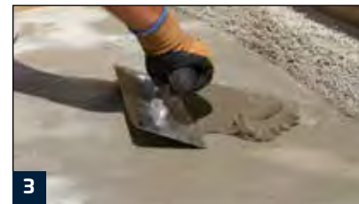
3 Auftrag des Mörtels auf den Untergrund
