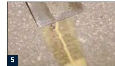
5 Überschüssiges Gießharz glattspachteln
