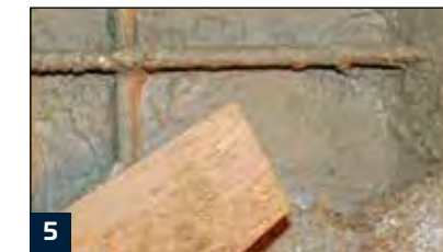
5 Renovation RM 2 Reparaturmörtel auf die frische Haftbrücke aufbringen
