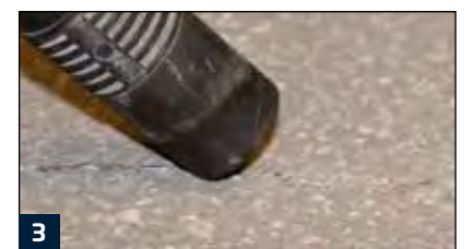
3 Säubern des Risses. (Absaugen)
