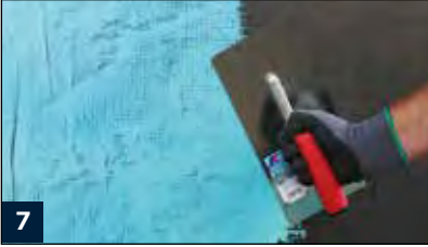
7 Nicht mineralische Untergründe wie Metall oder alte Bitumenabdichtungen säubern. Kratzspachtelung auf dem trockenen Untergrund auftragen.
