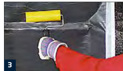
3 Andrücken der KSK-Bahn mittels Gummiwalze Aufkleben der Innenecken
