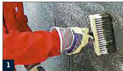
1 Grundieren des Untergrunds mit BE 901 bzw. B 97 L
