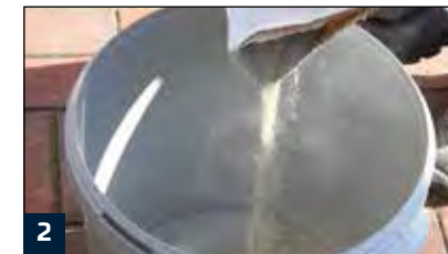
2 Einbringen des Pulvers in ganzen Gebinden
