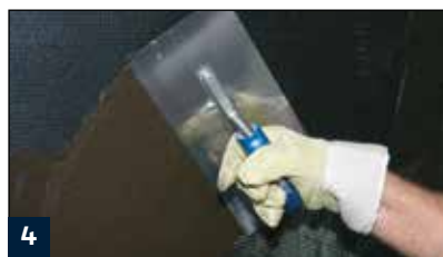
4 Auftrag der zweiten Lage BM 92 Schnell
