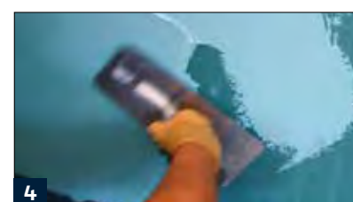
4 Aufbringen der ersten und zweiten Lage RD 2 The Green 1
