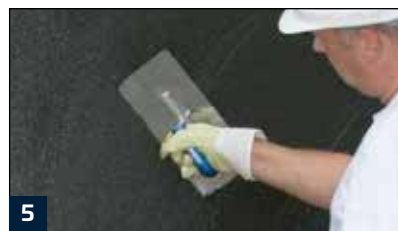
5 Vollflächiges Spachteln der zweiten Lage
