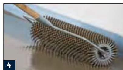
4 Entlüften der Ausgleichsschicht mit der Stachelwalze
