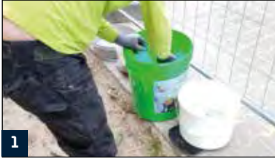
1 Zum Anmischen von RD 2 die Pulverkomponente in die Flüssigkomponente schütten. Bei der Entnahme von Teilmengen zuerst die Flüssigkomponente in einen sauberen Eimer geben.
