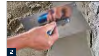
2 Ausgleichen unebener Wandflächen mit M 36 Speed in Schichtstärken bis 50 mm
