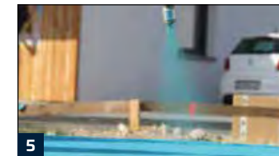
5 Nach Durchtrocknen der ersten Abdichtungslage wird die zweite Abdichtungsschicht ebenfalls im Kreuzgang aufgetragen.
