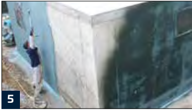
5 Abstand des Spritzkopfes vom Untergrund von etwa 20 bis 30 cm. I.d.R. kann bei maschineller Verarbeitung auf eine Kratzspachtelung verzichtet werden. Ungünstige Untergründe bilden bereits nach kurzer Zeit Blasen. In diesem Fall ist jedoch eine Kratzspachtelung erforderlich.
