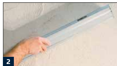
2 Glätten mit der Putzschiene
