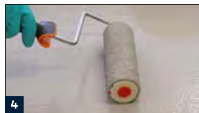
4 Aufrollen der Basisschicht BV 2 Versiegelung steingrau
