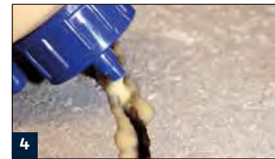
4 Schließen des Risses mit R 70
