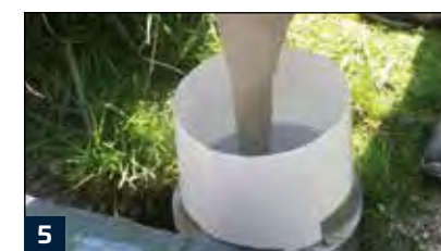
5 Einbringen in die vorbereitete Schalung
