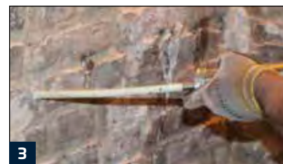
3 Injektion MS 10 mit Pumptechnik
