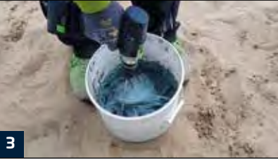
3 Pulver und Flüssigkeit maschinell mindestens 2 min verrühren (Empfehlung: Rührpaddle). RD 1 ist gebrauchsfertig und braucht nicht angemischt zu werden. Die Entnahme von Teilmengen vereinfacht sich dadurch.
