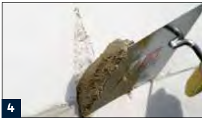
4 Egalisieren von Fehlstellen und Ausbrüchen mit M 35 oder M 36 Speed
