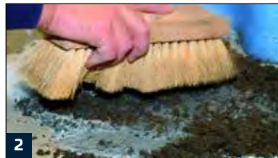
2 Einbürsten der Haftbrücke aus D 10 und angemischtem Estrich
