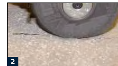
2 Optional Riss weiten mittels Flex
