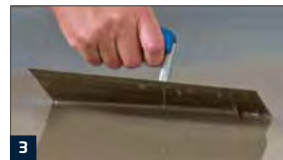
3 Verteilen der BOTAMENT®-Nivelliermasse mit dem Glätter
