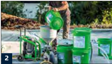
2 Besonders effektiv ist die Kellerabdichtung im Spritzverfahren, wenn die Maschine auf der Decke des Kellers platziert wird. Ohne störende Erdgeschosswände können alle abzudichtenden Flächen erreicht werden, ohne dass die Maschine versetzt werden muss.
