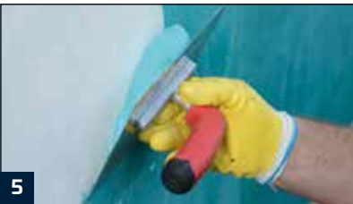
5 Zur Verbesserung der Haftung und zum Schließen von Poren und Lunkern RD 1 | RD 2 mit der glatten Seite eines Glätters auf den Untergrund aufkratzen (Kratzspachtelung).
