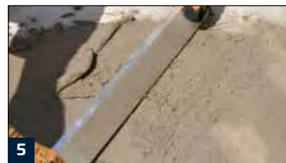
5 Abziehen und Eineben mit der Latte
