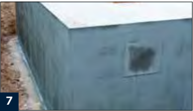
7 Die Schichtdicke wird über Schichtdickenmessungen und über den Materialverbrauch bestimmt. Mörtelschläuche und Förderpumpe sollten je nach Witterung nach 5-8 Gebinden mit Wasser und Schwammkugel gereinigt werden.
