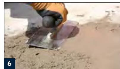
6 Glätten der Fläche mit der Kelle möglich
