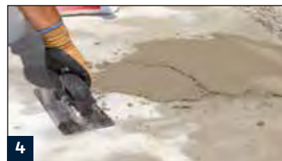
4 Einlagiger Auftrag bis zu 25 mm, zweilagige Flächenreparaturen bis zu 50 mm möglich
