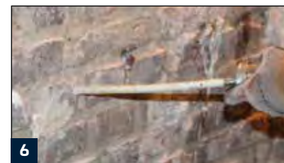
6 Bohrlöcher mit einer Saug- / Druckspritze vollständig mit MS 10 füllen.
