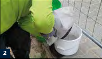
2 Pulverkomponente in die Flüssigkomponente geben. Teilmengen abwiegen. Die Waage muss dabei auf einem festen Untergrund stehen.
