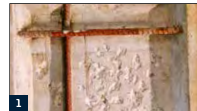
1 Bewehrungsstahl von Flugrost und losen Teilen befreien (Reinheitsgrad Sa 2 1/2)
