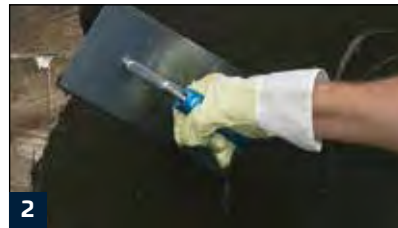
2 Auftragen der ersten Lage BM 92 Schnell
