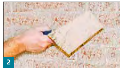
2 Netzförmiges Auftragen des Vorspritzmörtels RENOVATION VSM in Form eines Spritzbewurfs
