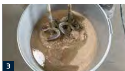
Zugabe von Quarzsand je nach gewünschter Mörtelkonsistenz
