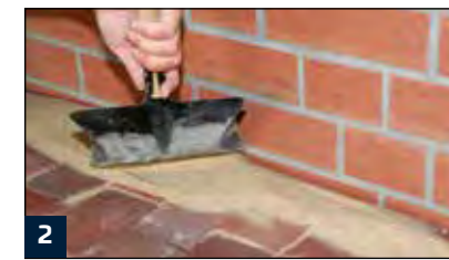
2 Bodenfläche vor der Wand mit Sand schützen
