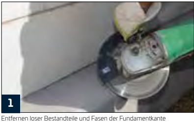
1 Entfernen loser Bestandteile und Fasern der Fundamentkante
