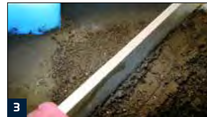
3 Estrich aufbringen in die frische Haftbrücke
