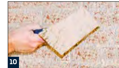
10 Netzförmiges Auftragen des Vorspritzmörtels Renovation VSM in Form eines Spritzbewurfs.
