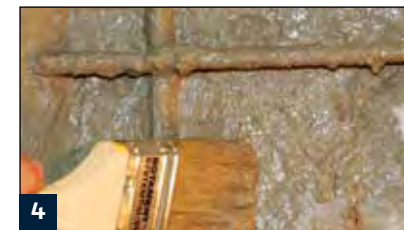
4 Betonuntergrund matt feucht vornässen und Haftbrücke aus Renovation HB 1 aufstreichen
