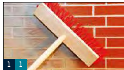
1 1 Vorbereitung des Untergrundes
