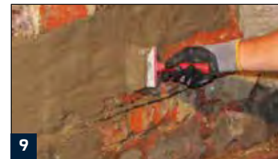
9 Sulfatbeständige Dichtschlämme MS 30 auftragen.
