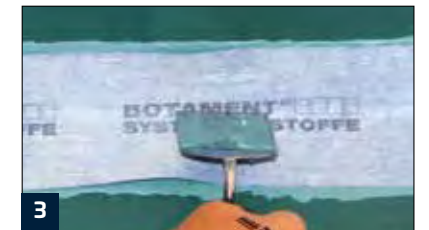
3 Herstellen des Wand-Bodenanschlusses mit SB 78
