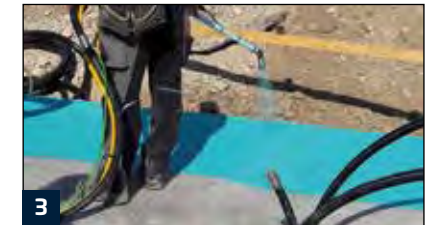
3 Untergrund vormäßen. Botament® RD 1 RD 2 im Kreuzgang aufspritzen.
