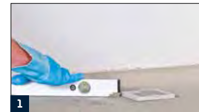
1 Einbau einer Gefälleschicht aus M 36 Speed in bodengleichen Duschbereichen
