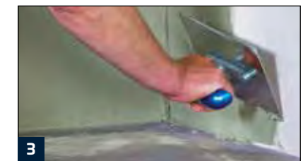
3 Dünnschichtiges, flächiges Aufziehen des Multimörtels M 35
