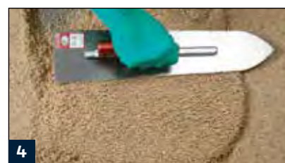
Auftragen des fertig gemischten Mörtels auf dem Untergrund (ab einem MV von 1:4 auf einer frischen Haftbrücke aus E 120)
