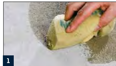
1 Vorwässern des Untergrunds
