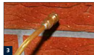
3 Auftragen von MS 80 W mit dem Spritzgerät
