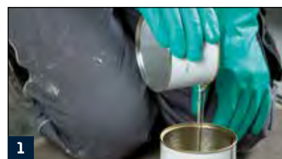
Anmischen des zweikomponentigen Bindemittels E 120/EB 100
