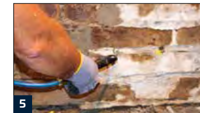
5 Bohrlöcher mit Druckluft reinigen.
