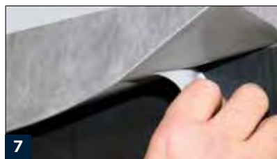
7 Überkleben des oberen Abschlusses der KSK-Bahn im Sockelbereich der Außenwand mit BOTAMENT®-Butyldichtband
