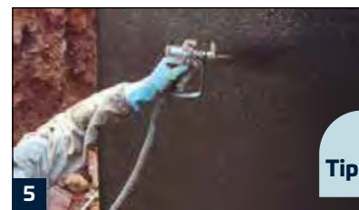
5 Zeitersparnis durch Auftragen von BM 92 Schnell im Spritzverfahren
