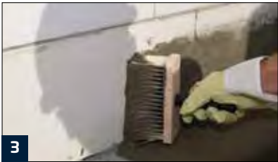
3 Schützen des Fußpunkts vor negativem Wasserdruck mit M 34 oder MS 30
