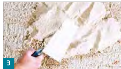
3 Aufbringen des Feuchtespezialputzes RENOVATION FSP
