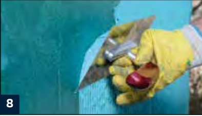
8 Erste Abdichtungslage auf der trockenen Kratzspachtelung auftragen. Um einen gleichmäßigen Materialauftrag bzw. Schichtstärke der Abdichtung zu gewährleisten Zahnglätter verwenden.
