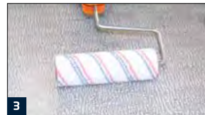
3 Aufrollen der Grundierung BV 2 transparent
