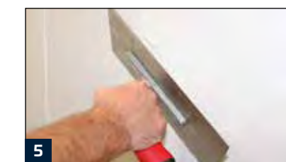
5 Auftrag von GS 4 Einsatz auf Gipskarton
