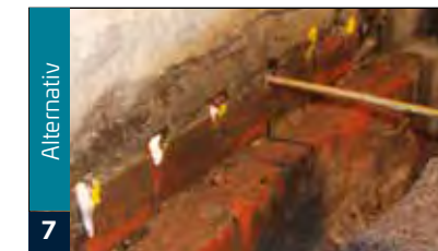
7 Alternativ Die Bohrlöcher können auch mit einem Drucksprünger gefüllt werden. Dabei sollte das Material mit wenig Druck verarbeitet werden.
