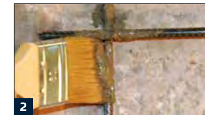
2 Gereinigten Stahl zweimal mit Renovation HB 1 streichen
