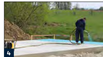
4 In der Regel kann bei maschineller Verarbeitung auf eine Kratzspachtelung verzichtet werden. Bei ungünstigen Untergründen kommt es nach kurzer Zeit zur Blasenbildung. In diesem Fall muss die übrige Fläche jedoch mit einer Kratzspachtelung versehen werden.
