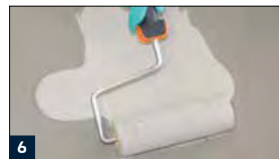
6 Aufrollen der Deckschicht BV 2 Versiegelung steingrau
