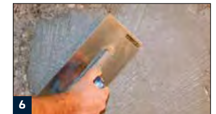
6 Glätten der Oberfläche mit Renovation BS 3 Betonfeinspachtel
