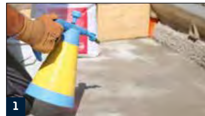
1 Vorwässern des Untergrunds
