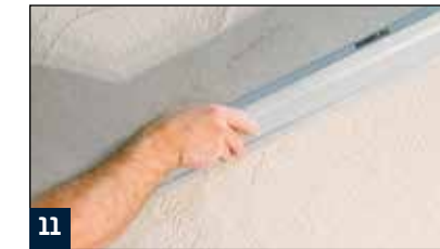
11 Aufbringen des Sanierputzes MS 20.
