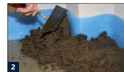
Aufbringen von M 54 Speed auf die Trennlage
