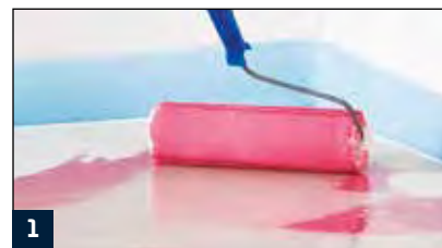
1 Grundierung von saugfähigen Untergründen mit D 11 Tiefengrund
