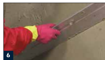
6 Abziehen und Glätten der Putzoberfläche
