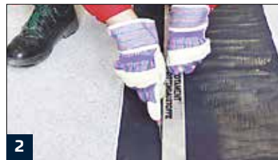
2 Zuschneiden der KSK-Bahnen mit Cutter
