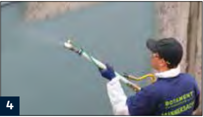
4 Persönliche Schutzausrüstung tragen. Spritzmaschine einrichten und Spritzbild einstellen. RD 1 | RD 2 auf mattfeuchtem Untergrund auftragen.
