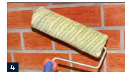
4 Auftragen von MS 80 W mit Rolle oder Quast
