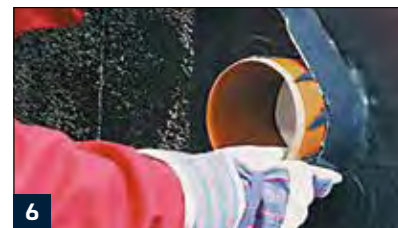
6 Abkleben von Rohrdurchführungen
