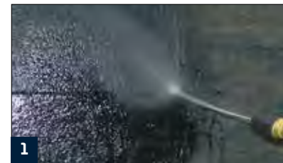
1 Untergrund reinigen z.B. mittels Hochdruckreiniger
