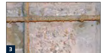
3 Korrosionsschutz aus Renovation HB 1 trocknen lassen
