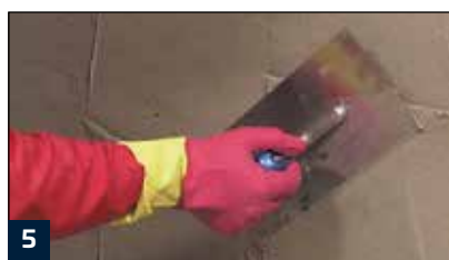
5 Auftrag des Sanierputzsystems
