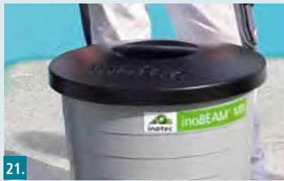
21. Bei direkter Sonneneinstrahlung Materialbehälter abdecken!
