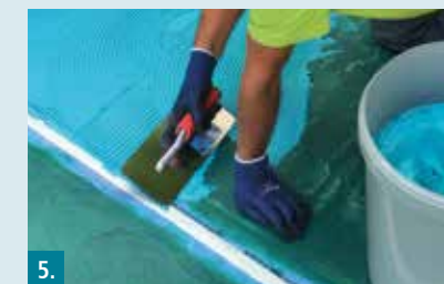
5. Erste Abdichtungslage aus RD 1 | RD 2 mit einem Zahnglätter auftragen.
