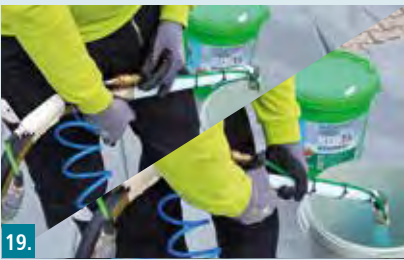
19. Spritzgang immer in dieser Reihenfolge beginnen und in umgekehrter Reihenfolge beenden: 1. Förderpumpe starten 2. Luftzufuhr öffnen 3. Materialzufuhr öffnen
