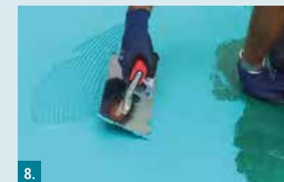
8. Zweite Abdichtungsschicht aus RD 1 | RD 2 in gleicher Arbeitsweise auf der getrockneten ersten Lage aufbringen.
