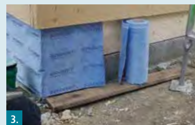
3. Portalichtband 15 cm über Geländeoberkante fixieren.
