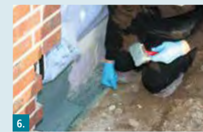
6. Untergrund mit RD 2 (Auftrag mit Pinsel, Quast oder Zahngläter)
