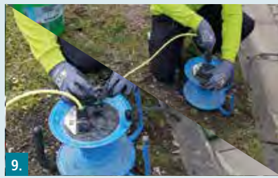
9. Netzschalter der Förderpumpe an 230 V anschließen, bzw. abschließen.
