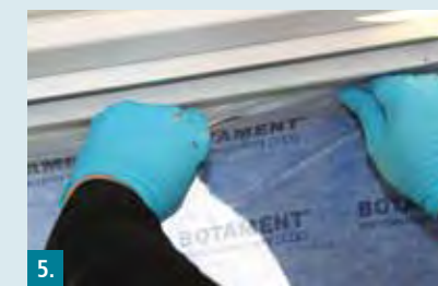
5. Zugeschnittenes Portaldichtband mit dem Klebestreifen am Fensterahmen fixieren.
