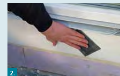
2. Untergrund mit Schleifpapier anrauen.
