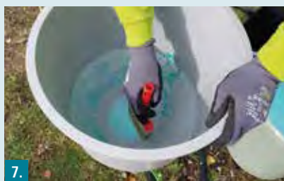
7. Mörtelbehälter mit geeignetem Werkzeug reinigen.
