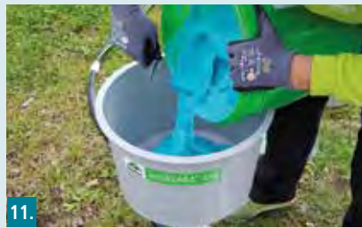
11. RD 1 | RD 2 in den Materialbehälter füllen.
