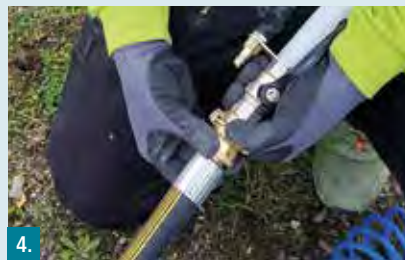
4. Mörtelschlauch und Spritzkopf verbinden.
