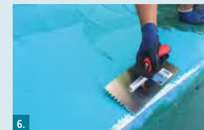
6. Zahnstege im frischen Zustand glätten ohne Material zu entfernen.
