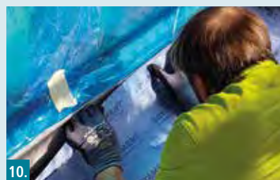
11. PB Portaldichtband mit Klebeband provisorisch am Fenster fixieren.
