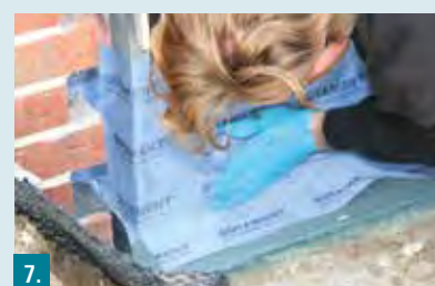
7. Portaldichtband in die frische Reaktivabdichtung einbetten.
