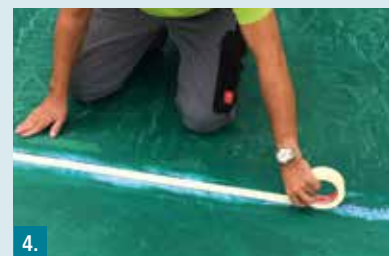
4. Dehnzonen in den Dichtbändern mit Klebeband abdecken.
