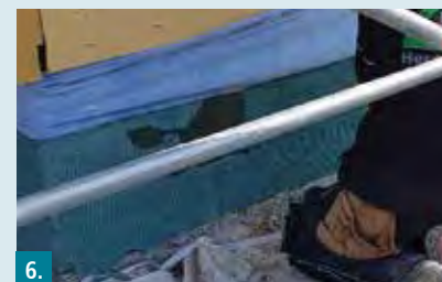
6. Auf der durchgetrockneten Kratzspachtelung vollflächig RD 2 mit einem Zahnglätter aufziehen.
