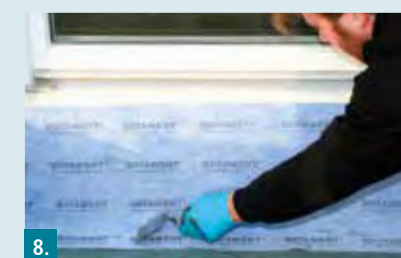
8. Portaldichtband sorgfältig in die frische Abdichtung einstreichen.
