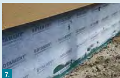
7. Portalichtband faltenfrei einbetten.
