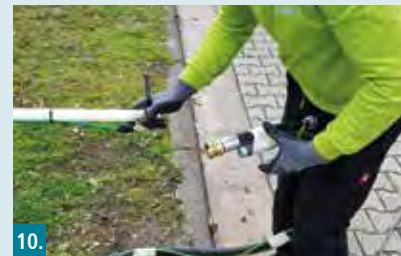
10. Spritzkopf demontieren.
