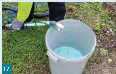
17. Solange Wasser fördern, bis unverdünntes Material aus der Düse kommt.
