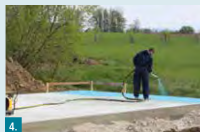
4. In der Regel kann bei maschineller Verarbeitung auf eine Kratzspachtelung verzichtet werden. Bei ungünstigen Untergründen kommt es nach kurzer Zeit zur Blasenbildung. In diesem Fall muss die übrige Fläche jedoch mit einer Kratzspachtelung versehen werden.
