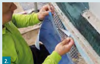
2. Klebestreifen an der Rückseite des Portalichtbands abziehen.
