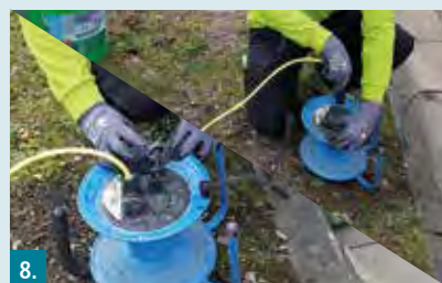
8. Kompressor und Förderpumpe vom Strom trennen.
