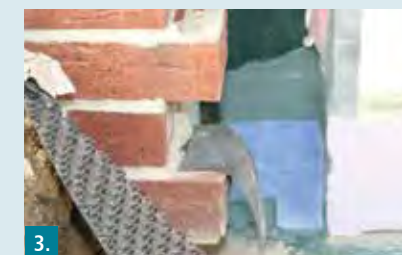
3. RD 2 mit einem Quast oder Pinsel auftragen und Formteile (hier Innenecken) einsetzen.
