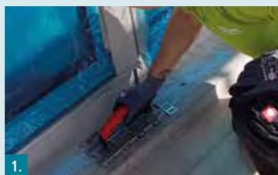
2. Fensterelemente mit Gitterschleifer oder Schleifpapier anrauen.
