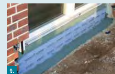
9. Übergänge vom PB Portaldichtband zur vorhandenen Bauwerksabdichtung und zum Fensterelement mit einem Quast oder Pinsel großzügig überarbeiten.
