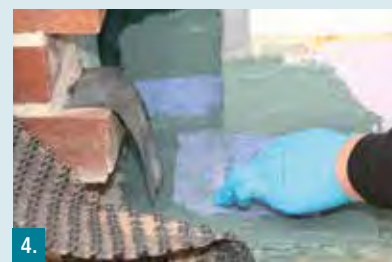
4. RD 2 mit einem Quast oder Pinsel auftragen und Formteile, hier Außenecken, einsetzen.
