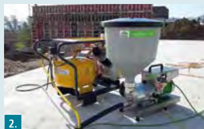
2. Bei maschineller Verarbeitung Spritzmaschine einrichten.
