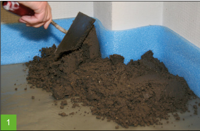
Aufbringen von BOTAMENT M 56 Speed auf die Trennlage.
